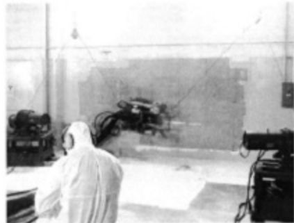
Figura B, Atelierul Decon, aplicarea ERWS pentru îndepărtarea vopselei de pe pereți
